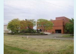
上越市下水道センター (春日山周辺地域)
