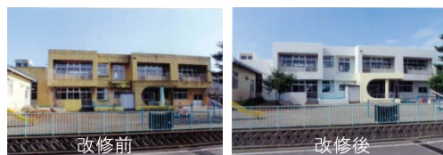
施設の老朽化による再塗装のため、全面的に色彩変更した事例です。(増築部分除く)
