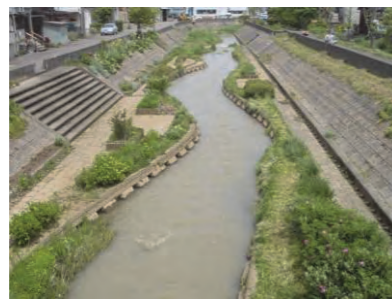
青田川河川環境整備による親水公園 (高田周辺地域)
