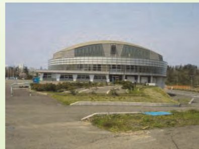
柿崎総合運動公園 (柿崎地域)
