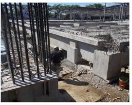
▲ 現場では鉄筋の組立て、継ぎ手、型枠の組み方、養生、型枠を外す順序等、コンクリートの打設 前後の注意点を説明しました。(写真はホール棟の北東部)
