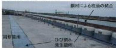
※ 地下水位上昇に伴い鋼管矢板のたわみが増加、舗装面の一部にひび割れ。たわみは設計当初から想定していたもので、鋼管矢板の健全性・遮水性能への影響なし。鋼管矢板への鋼材補強、ひび割れの補修を実施済。
