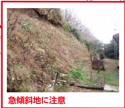
● 横穴が急傾斜地に点在しており、崩落のおそれあり
