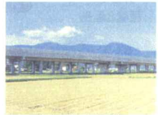
板倉区(明かり区間)
