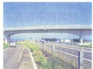
上新バイパス架道橋
