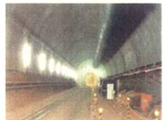
松ノ木トンネル覆工完了箇所
