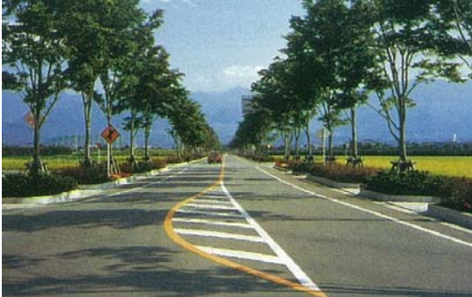
山梨県甲府市 列植により山並みへの視線を強調
