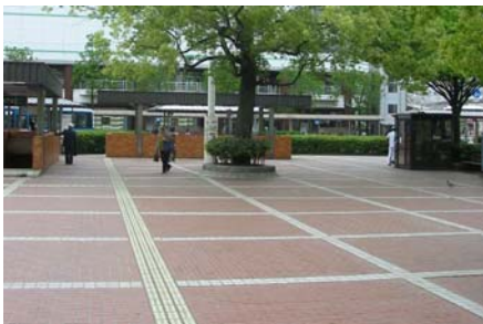
広島県呉駅前広場 舗装パターンに組み込まれた視覚障害者誘導用ブロック
