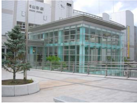
JR 山形駅 駅前面へのガラス構造の採用による自然採光
