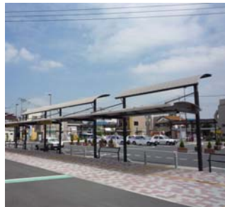
幸手市幸手駅前広場 車両乗降時の降雨に配慮したシェルター
