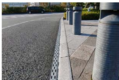
段差をなくし、雨の日でも 歩きやすい舗装(透水性)に(静岡県沼津駅)
