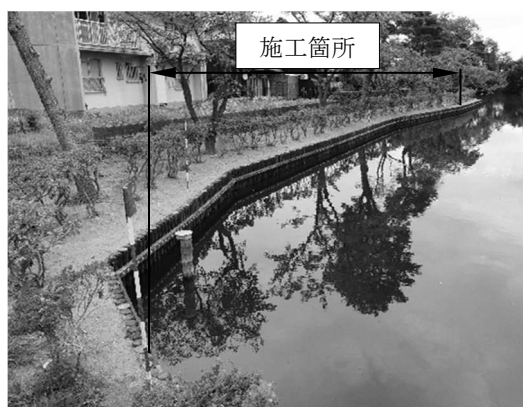
内堀護岸詰杭更新工事
