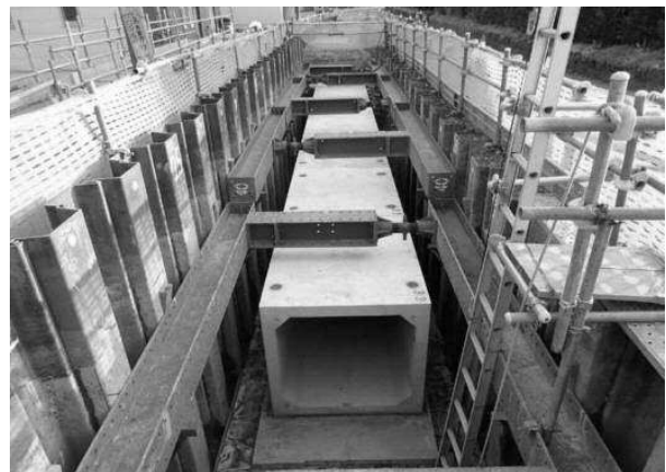
〔雨水管渠工事（寺町一丁目地内）〕
