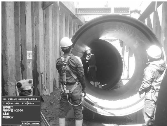
〔雨水管渠工事（北城町一丁目地内）〕
