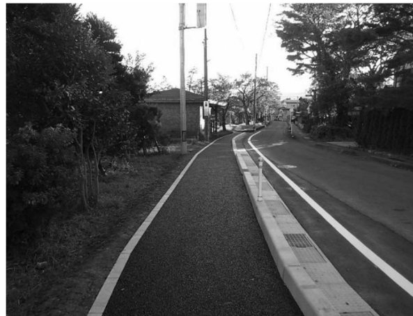
園路新設（高田城址公園）
