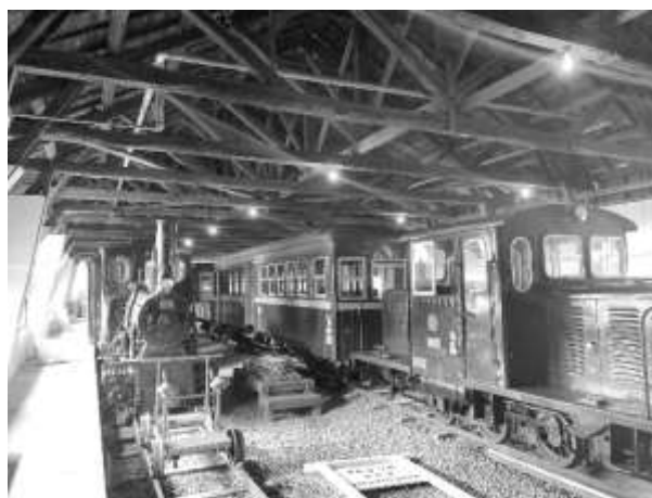
旧頸城鉄道機関車庫天井部（整備後）
