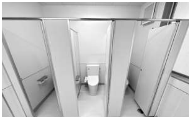
春日小学校校舎トイレ改修状況
