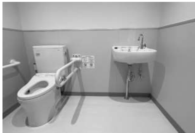
春日中学校体育館トイレ改修状況
