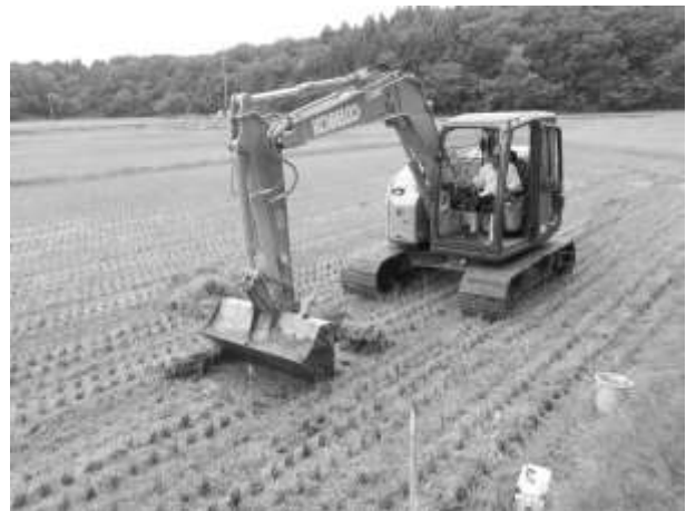
県営ほ場整備事業・原之町地区 試掘調査風景
