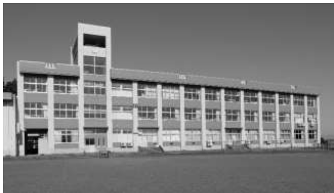
黒田小学校外壁改修状況
