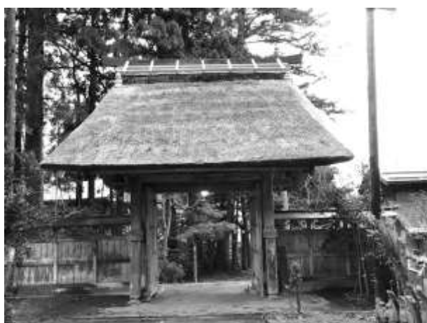
楞嚴寺山門（整備後）
