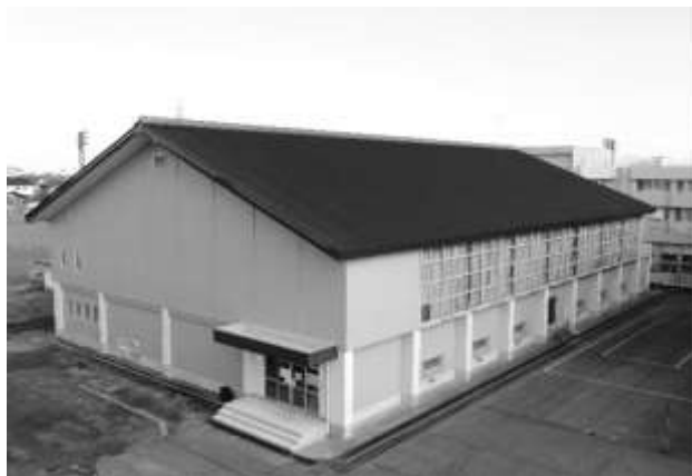
春日中学校体育館屋根・外壁改修状況
