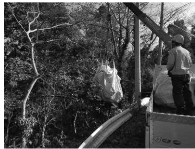
<回収作業の様子>
