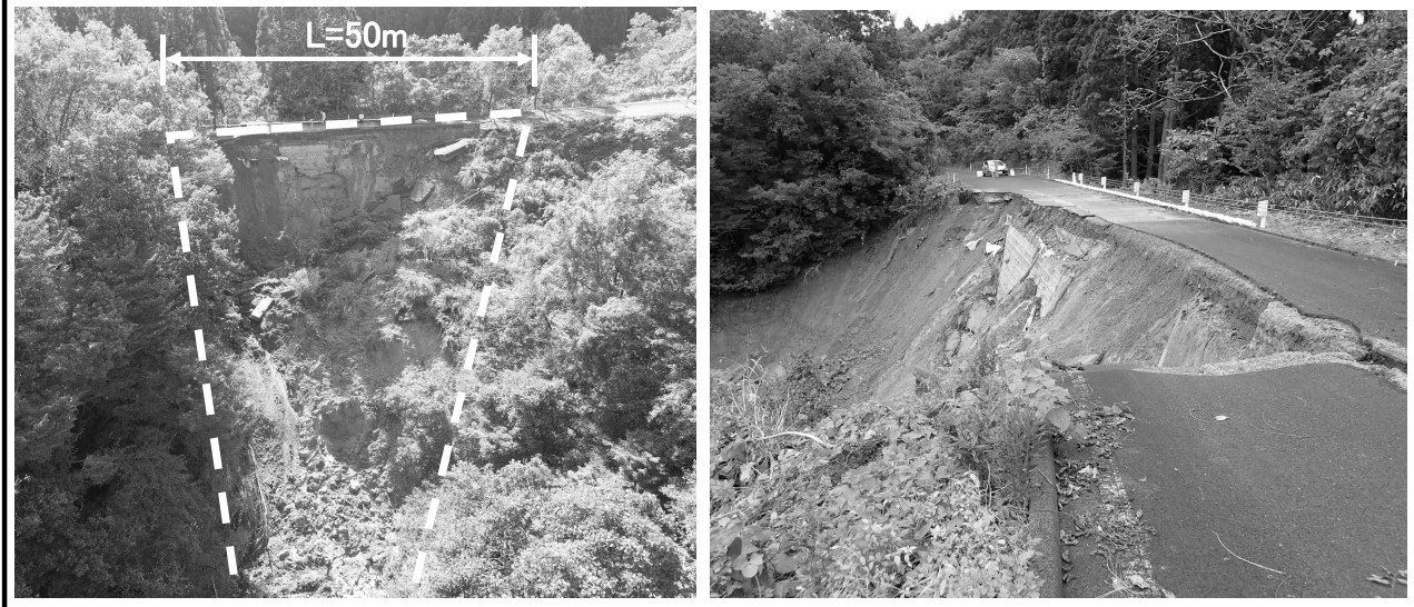
[ 被災状況 (令和5年10月) ] 道路法面の崩落
