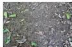
道を整備するときは、このように細かい砂利を引くのがよいのだけ
