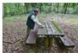
D 朽ちてきているベンチは改修必要
