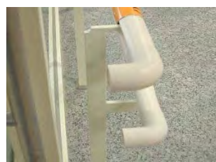
写真-14, 15 二段の手摺り、手摺りの端部処理
