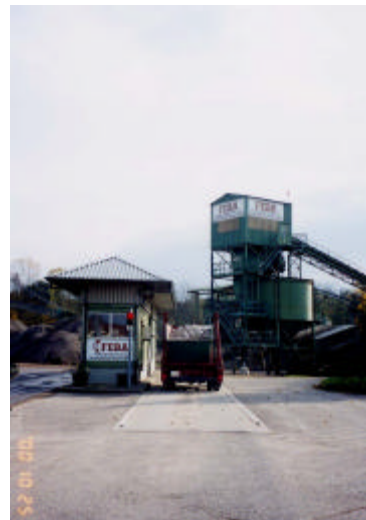
写真 5 フェーバ社 建築廃棄物を積んだトラックが入構中である
