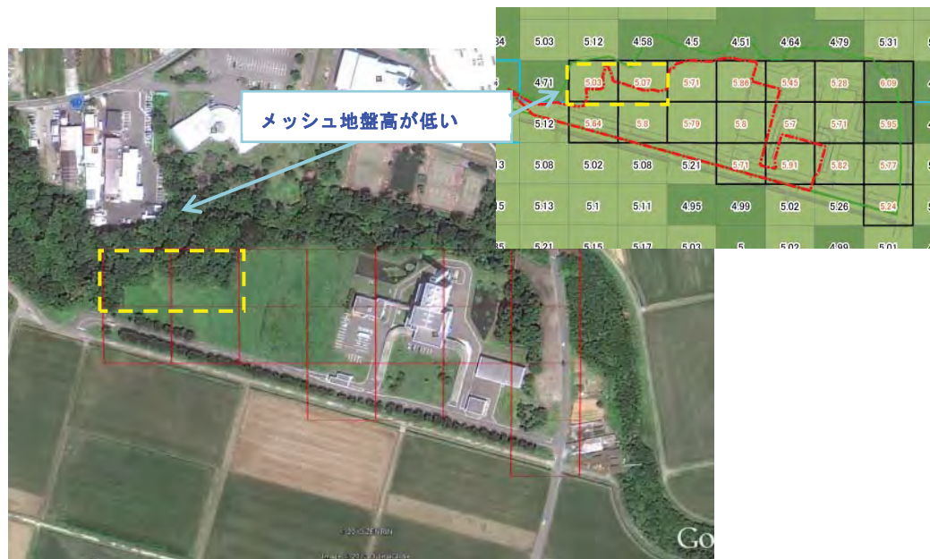
図 4-9 クリーンセンター敷地の航空写真
