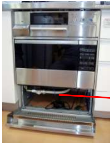
機器接続ガス栓
