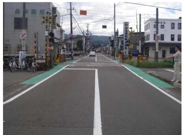
【路面標示設置】
