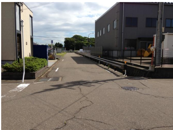
【転落防止柵設置】
