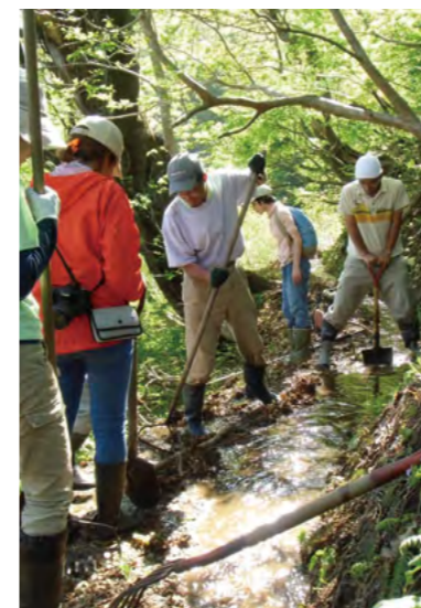
地域住民とボランティアによる農業用水普請の様子(吉川区 川谷地区)
