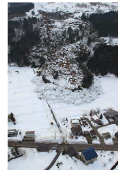
平成24年3月7日に発生した地すべり(板倉区 国川地区)(新潟県提供)
