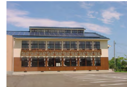
▲ 太陽光パネルを設置した校舎（春日小学校）
