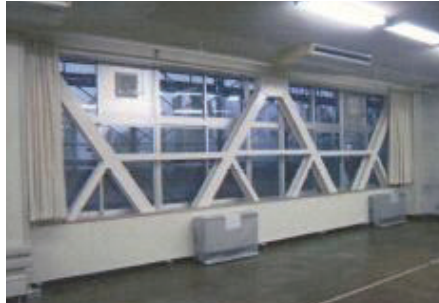
▲ 校舎の耐震化（高田西小学校）
