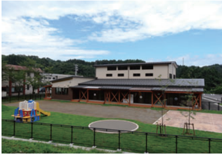
▲ 谷浜・桑取地区の4つの保育園を統合して新築されたにはま保育園
