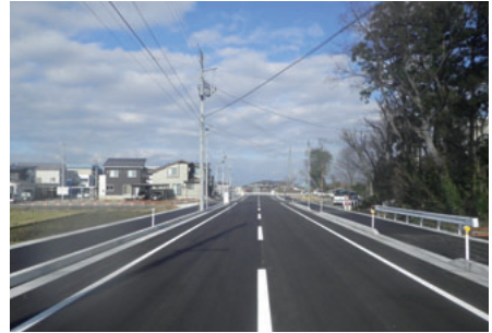
▲ 歩道が整備された快適な市道
