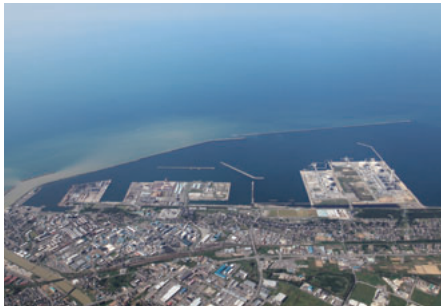
▲ 直江津港の全景
