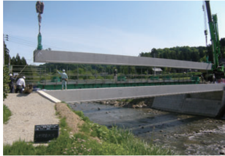
▲ 市道橋梁工事の様子（安塚区 大原橋）
