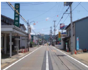
主要地方道新井柿崎線(板倉区針)
