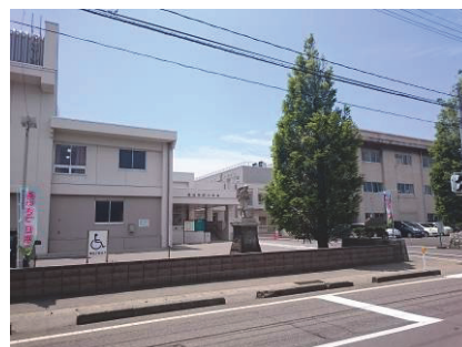
改築した春日新田小学校 (直江津周辺地域)
