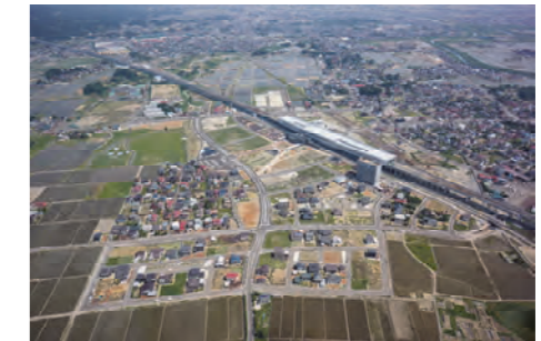
上越妙高駅西口と釜蓋遺跡
