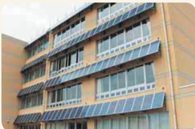
▶ 太陽光パネル (大町小学校)
