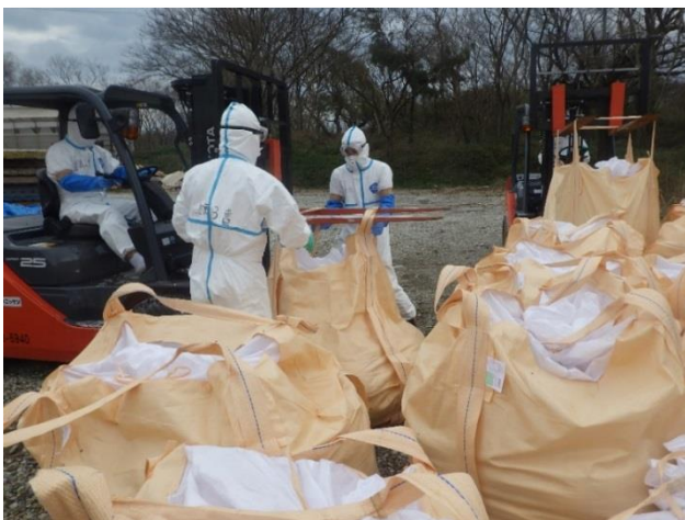
④袋詰め後、重機を用いて埋却場所へ移動
