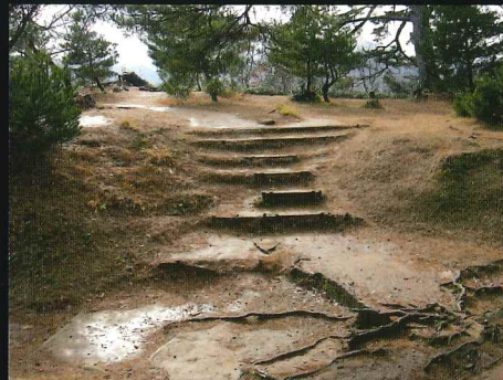
雨水等による流土 (天守台跡)
