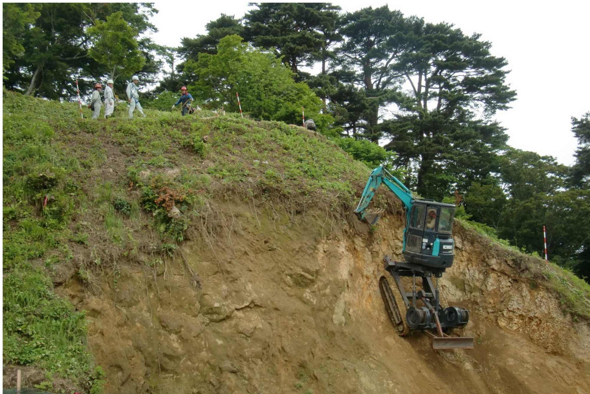
重機は、山の上の木からワイヤーで釣って作業をしています。6月13日
