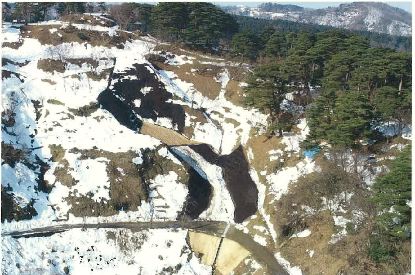
現地工事完了後 平成 29 年 12 月 23 日
