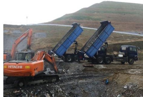
遮水シートに覆われた管理型最終処分場に埋め立てています。
