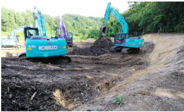
① 山側の L 型擁壁裏付近から谷側を撮影 (H30.6.14)
