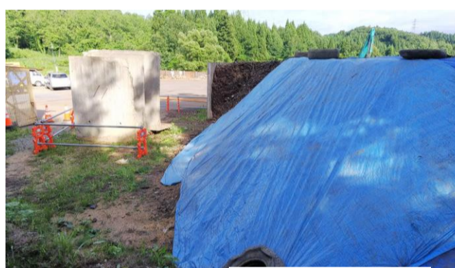
② 山側の L 型擁壁付近を撮影 (H30.6.14)
