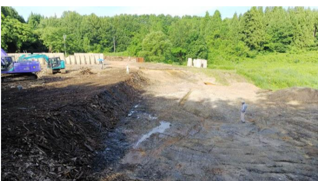
⑥ 廃棄物撤去後の谷側付近を山側から撮影 (H30.6.14)
