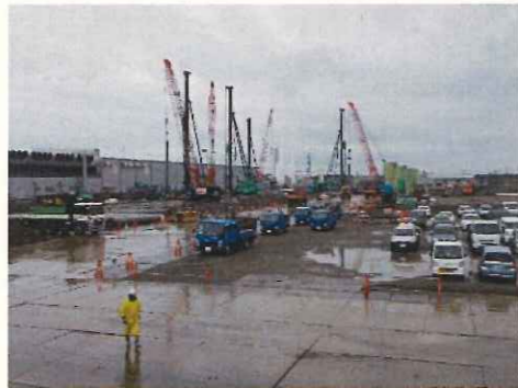
～5台の杭打機にて杭工事を施工しました～（～5月末）
