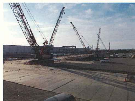
～現在の工事施工状況です～（全景）
