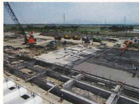
～杭打工事後の基礎工事～
