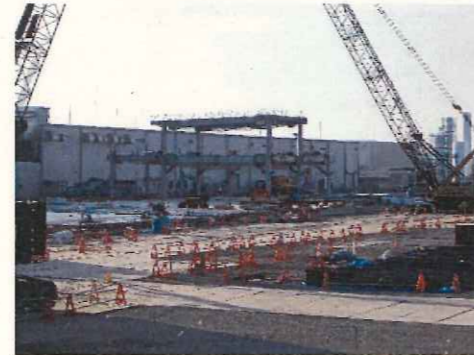
～現在の工事施工状況です～（鉄骨組立）
