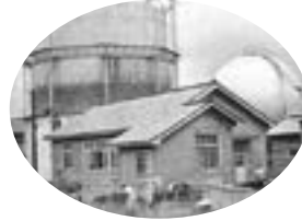
川原町ガス供給所
