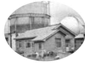
川原町ガス供給所
