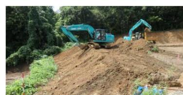
▲⑦成形…谷側の斜面を削り、安定勾配を確保し、土砂の崩落を防ぐ。
