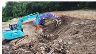
▲②選別…回転式とグローブ型の重機の連携により作業効率を上げる。
