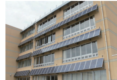
▲太陽光パネルを設置した校舎（大町小学校）
