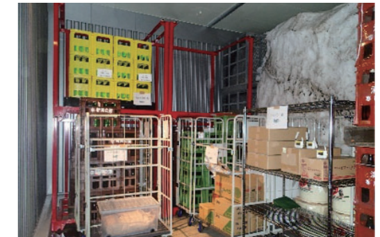
▲雪冷熱を活用した施設（安塚区信濃坂・雪室）
