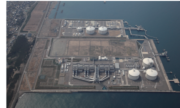
▲火力発電所が立地する直江津港・荒浜ふ頭 (新潟県提供)
