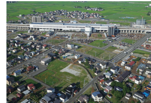
▲土地利用が進む上越妙高駅周辺
