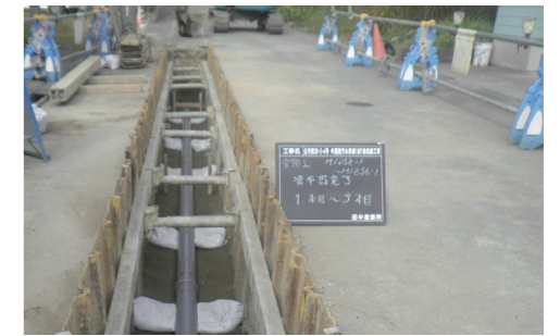
▲下水道管の埋設工事
