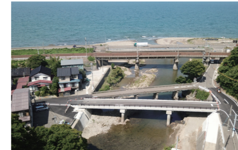
▲新設された市道橋（有間川橋）
