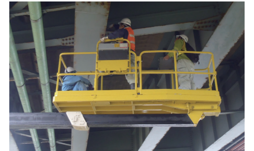
▲橋梁の点検作業
