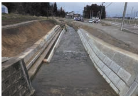
▲改修された河川（準用河川前川）
