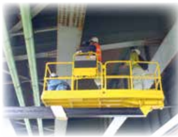
▲橋梁の点検作業
