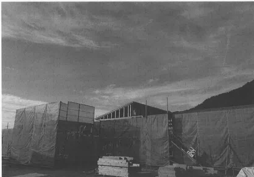
名立区新保育園 建設状況写真
