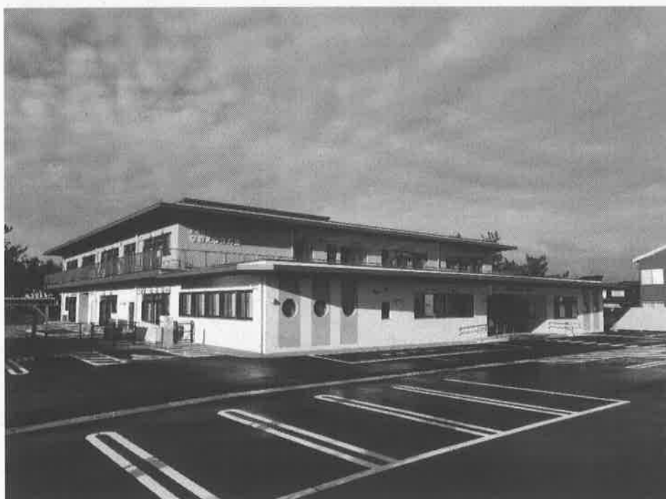
なおえつ保育園 完成写真
