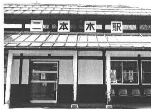
二本木駅駅舎の東面外観
