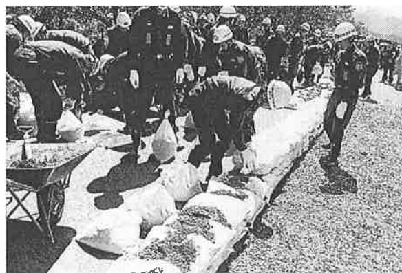
【水防訓練における上越市消防団の木流し工（左）、積み土のう工（右）】
