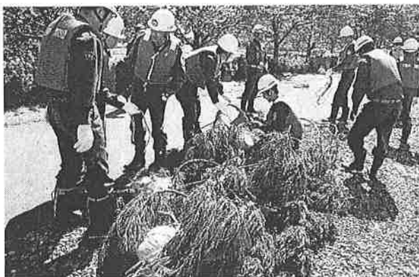
【水防訓練における上越市消防団の木流し工（左）、積み土のう工（右）】
