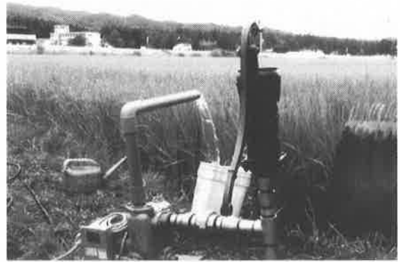
[井戸設置による用水確保]
