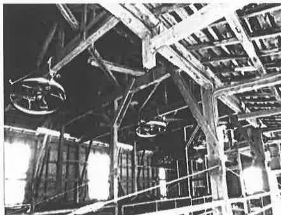
[送風換気設備による暑熱対策]
