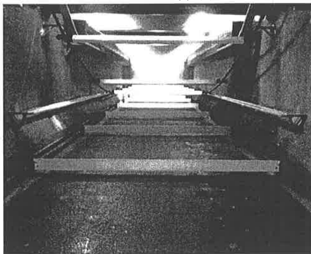
最初沈殿池汚泥掻寄機更新 (機械設備工事)
