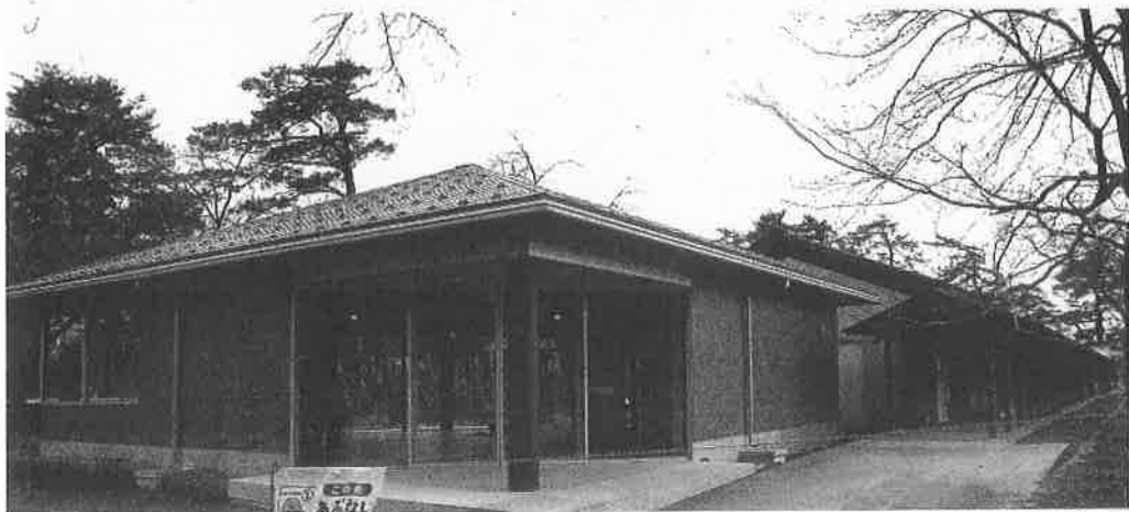
現況写真（多目的室側） 令和2年1月撮影
