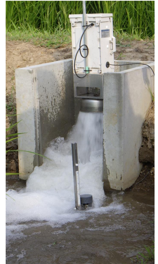
写真: 給水状況
