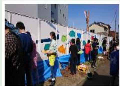
壁面作成作業
