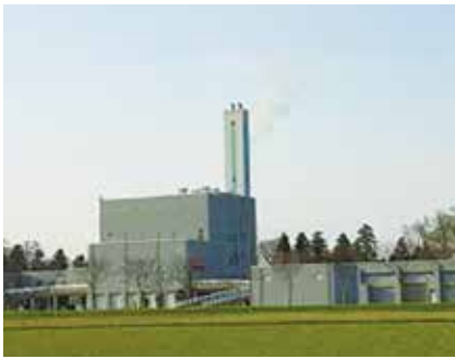
除却予定の旧第2クリーンセンター
